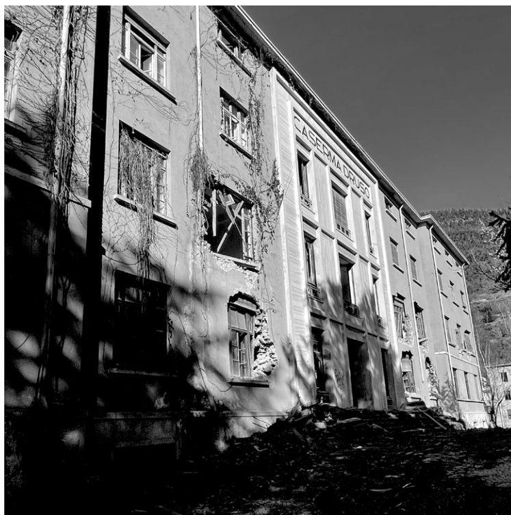
Fig. 1. Silandro (BZ), Ex Caserma Druso. Facciata della Palazzina Comando parzialmente demolita (foto A. Zampini 2023).
