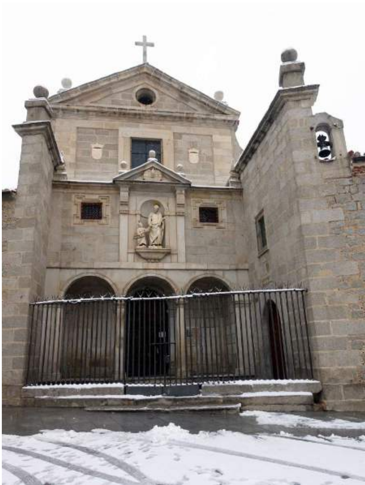
2. Ávila, Convento de San José, Façade, Francisco de Mora
