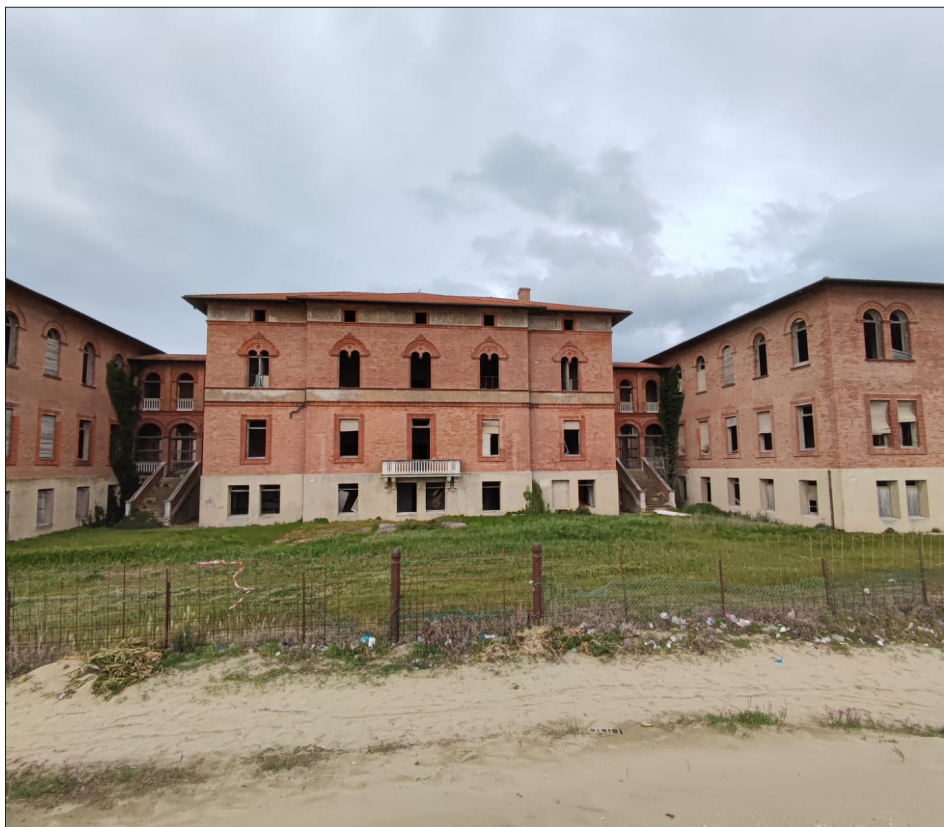
Fig. 1. L'ex colonia Bolognese, Miramare di Rimini, fronte spiaggia [foto Mirella D'Ascenzo, 2023].
