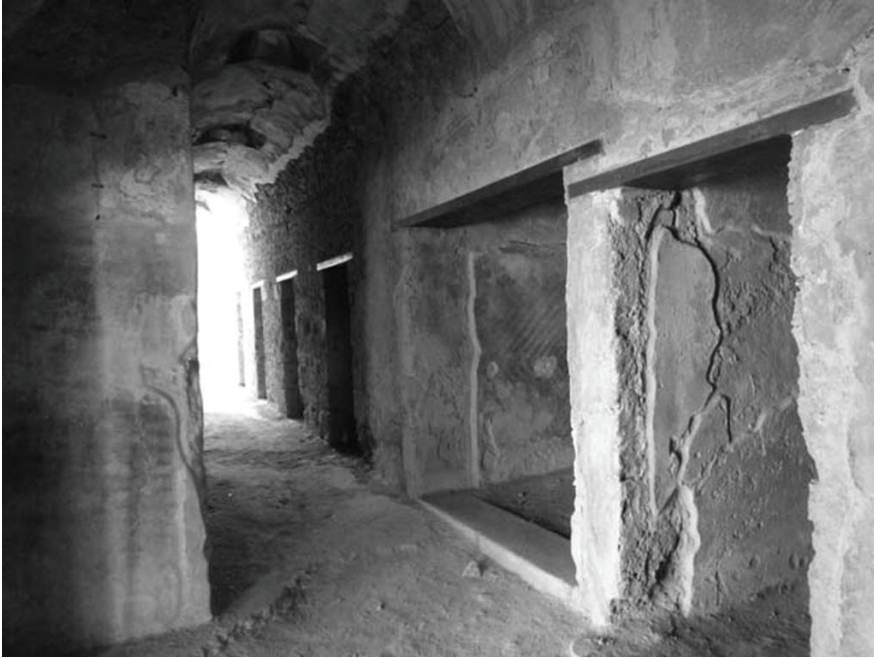
Fig. 2 – Pompei. Terme Stabiane. Il corridoio e le stanzette da bagno della fase più antica (V-IV sec. a.C.).
