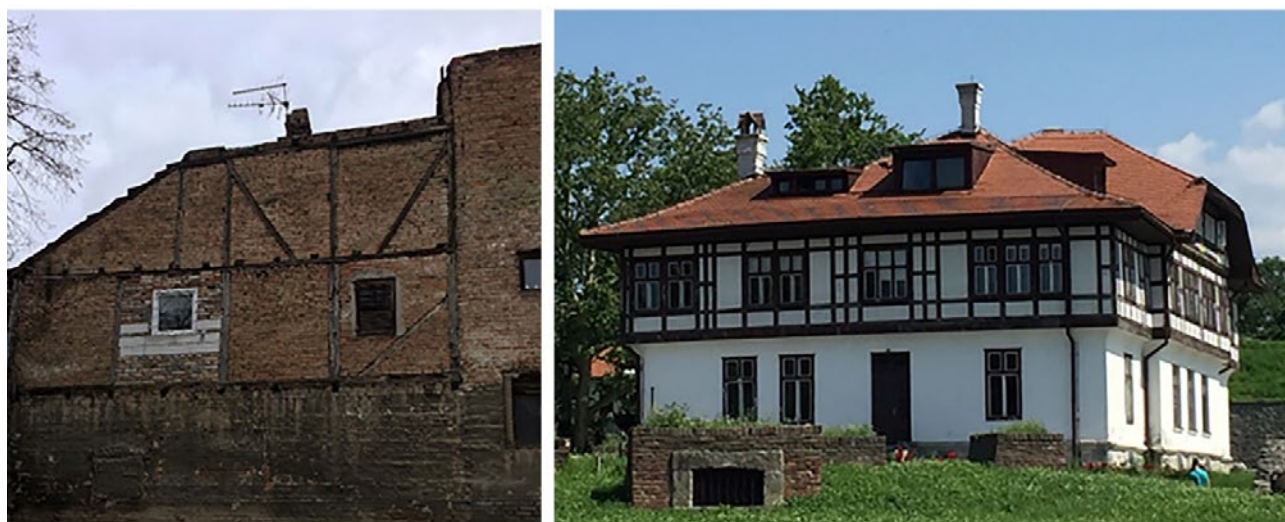
Fig. 2. Esempi di tecniche costruttive comuni nella Serbia del XIX secolo: a sinistra, muratura tamponata con struttura in legno in un edificio residenziale a Belgrado; a destra, Istituto per la protezione dei monumenti culturali, di Belgrado – © 2021, S. Brzev.
