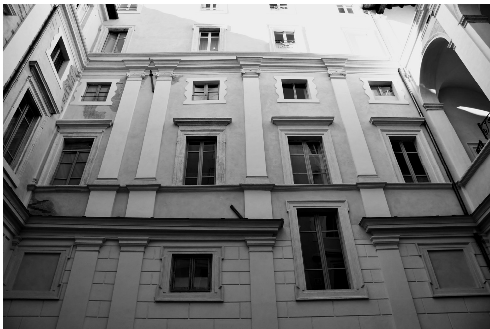
Fig. 4. Zona centrale del fronte ovest del cortile dopo il restauro. Foto Aurea Sectio.
