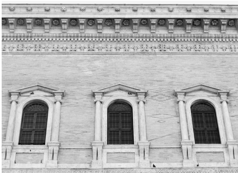
Fig. 7. Palazzo Farnese a Roma, dettaglio del secondo piano con le decorazioni ottenute dalla disposizione alternata di mattoni giallo-rosati e rossi. Foto M. Antonucci.
