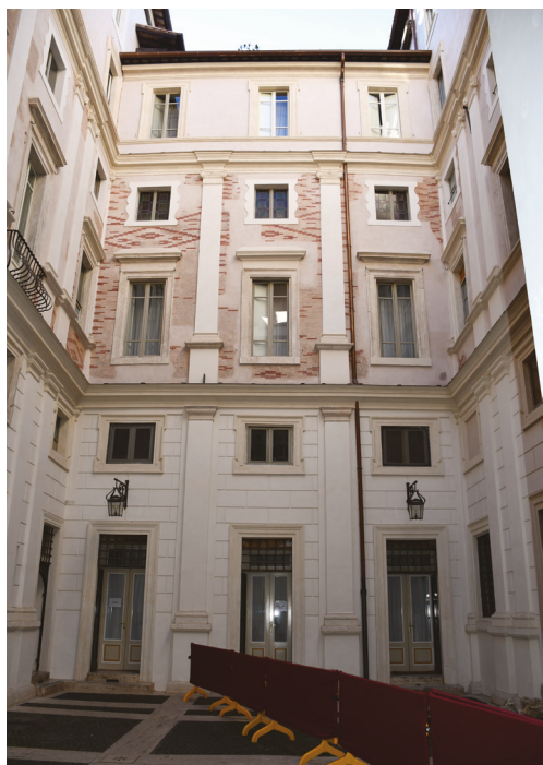
Tav. III. Il fronte sud del cortile dopo il restauro. Foto Aurea Sectio.
