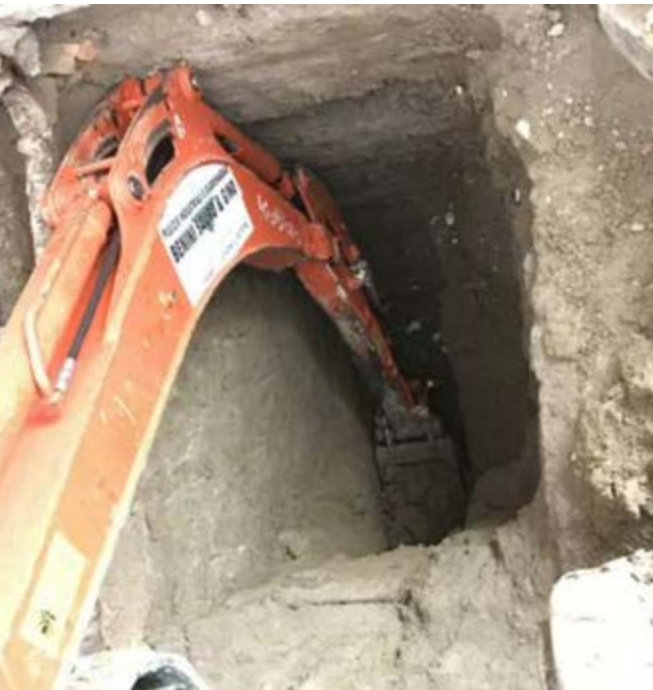
Figura 12. Indagini strutturali: in alto, la messa in luce di elementi verticali in c.a.; in basso, indagini sulle fondazioni all'angolo nord-est (da Linee Guida per lo sviluppo della Progettazione , 31.07.2020).
