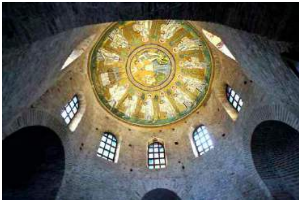
Fig. 51. Vista generale interno, Ph. Stefano Possenti.
