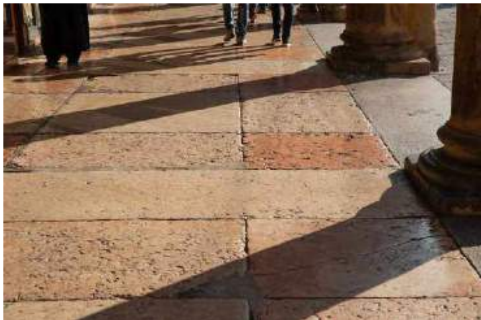
Fig. 32. Pavimento portico del Pavaglione con pietre di grande pezzatura, Ph. N. La Terra.
