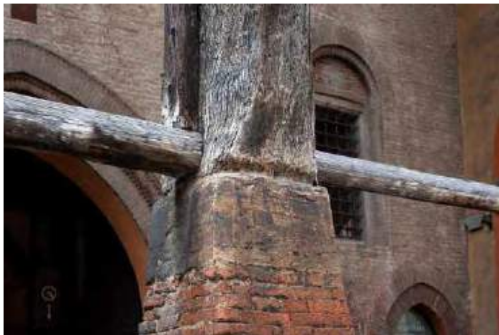
Fig. 10. Particolare piedistallo in muratura del portico di Palazzo Isolani, Ph. Nicola La Terra.
