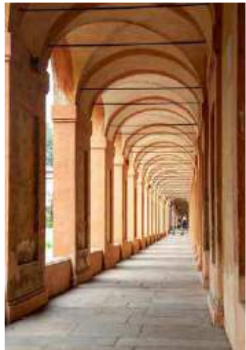
Fig. 34. Pavimentazione portico di San Luca in pietre di Luserna, Ph. Nicola La Terra.
