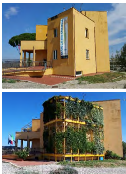
Fig. 2 Edificio verde (Scuola delle Energie). Aln alto, l'edificio prima dell'installazione di coltre vegetale; in basso, l'edificio con coltre vegetale
