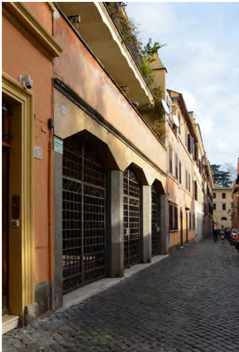
Figura 14. Unità Edilizie prospettanti su via dei Riari (UU-A 7). La presenza del portico al piano terra della particella catastale n. 244 incide sulla valutazione delle “Vulnerabilità costruttive” e partecipa alla definizione dell’indice globale I_v (foto M.G. Ercolino, 2023).
