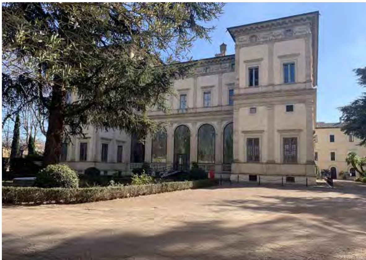
Figura 13. Il fronte nord della Villa Farnesina. L'impostazione cromatica generale delle facciate della villa è dovuta ai restauri condotti sotto la direzione dell'Arch. G. Belardi per la S.B.A.P. della città di Roma (foto M. Caperna, 2023).
