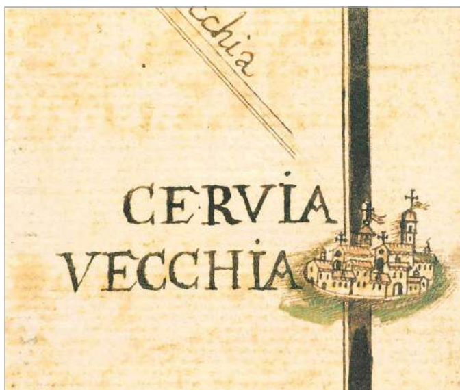
fig. 3.13 – Pianta del territorio compreso tra il Savio, Cervia nuova e vecchia, particolare, G. Guizzetti, 1703 (Archivio Storico Comunale di Ravenna, Cancelleria, vol. 726 = La città dei “divini alberi” , n. 28.1, p. 82).
