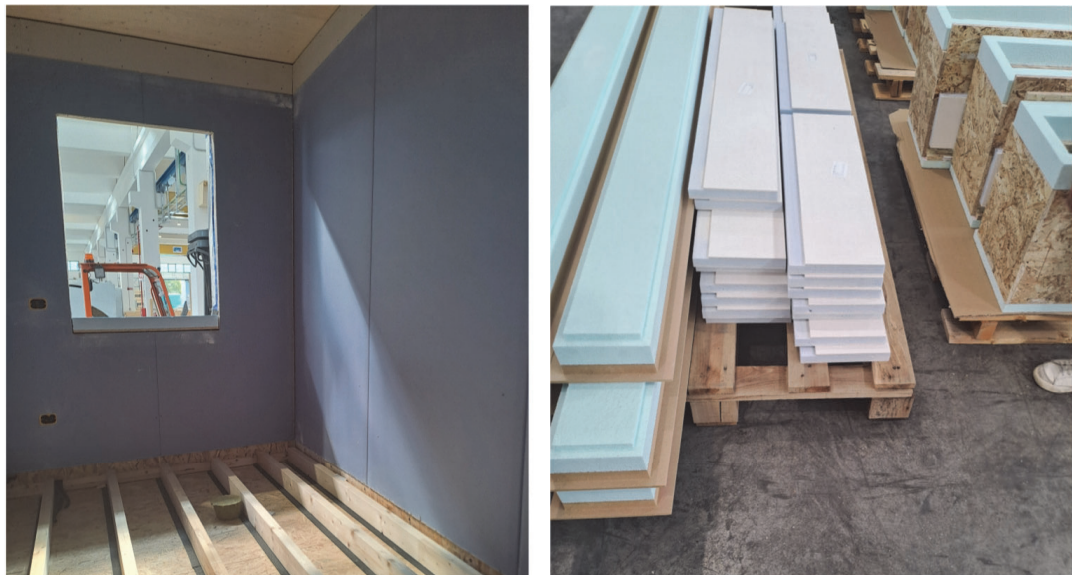
Figura 8.3 – Progettazione circolare già dalle fasi di produzione: l'elemento diagonale utilizzato per irrigidire il modulo abitativo prefabbricato in fase di trasporto sarà utilizzato nei collegamenti verticali dell'edificio. Fonte: Foto degli autori. Courtesy Marlegno.
