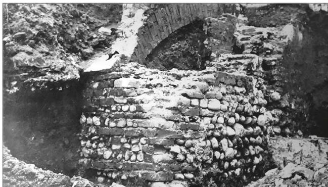
fig. 76. Foto del muro ad angolo in ciottoli e tavelloni romani trovato durante gli scavi per la costruzione dell'Albergo Roma (da SABAP-BO, pratiche di scavo, S2).
