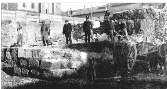
fig. 36. Operai intenti nella demolizione della struttura in blocchi lapidei a base rettangolare addossata alle mura tardoantiche rinvenute durante i lavori per la costruzione del Palazzo I.N.A. (da PAGLIANI 1991, p. 35, fig. 22).
