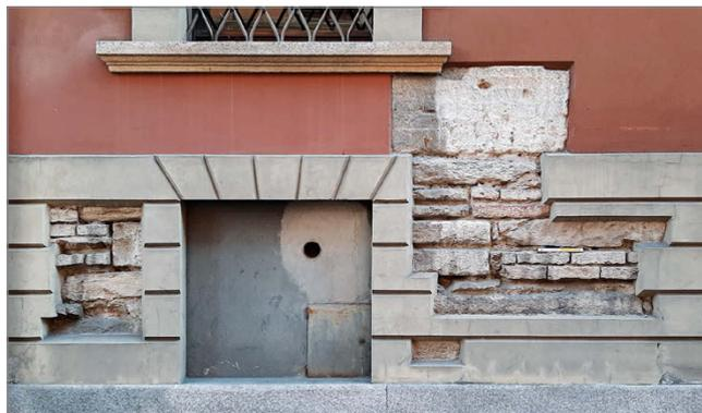
fig. 40. Parte delle mura urbane tardoantiche costituite da sesquipedali ed elementi architettonici di reimpiego, inglobate nella facciata del Palazzo del Monte di Pietà su cantone del Monte (foto dello scrivente).
