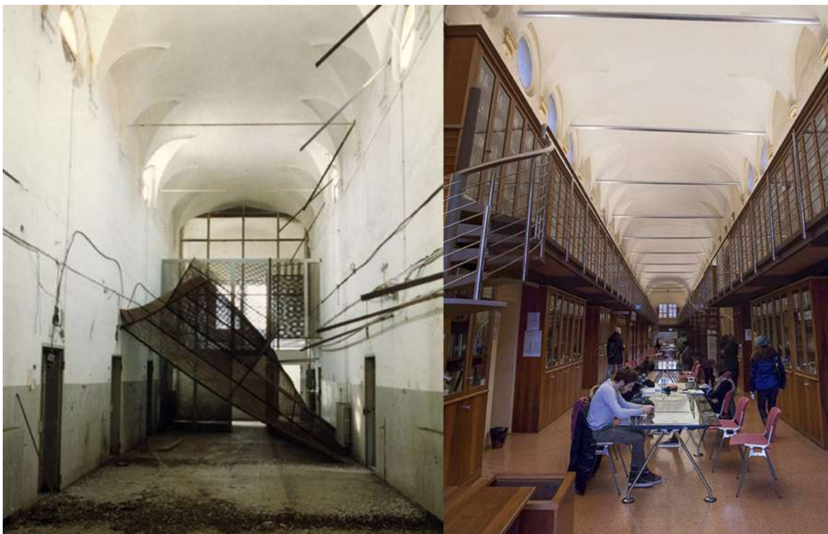
Fig. 38 - Bologna, complesso di San Giovanni in Monte: la manica al secondo piano prima e dopo i restauri.
