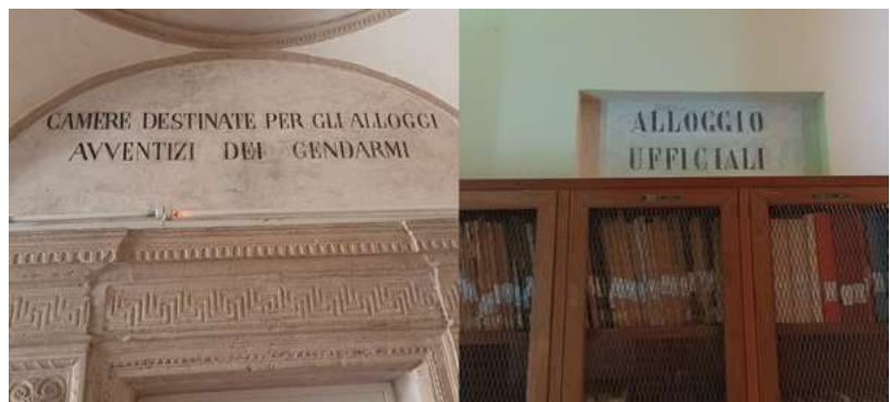
Fig. 1 - Tracce ancora visibili della precedente funzione carceraria. Bologna, complesso di San Giovanni in Monte, primo piano e manica al secondo piano.
