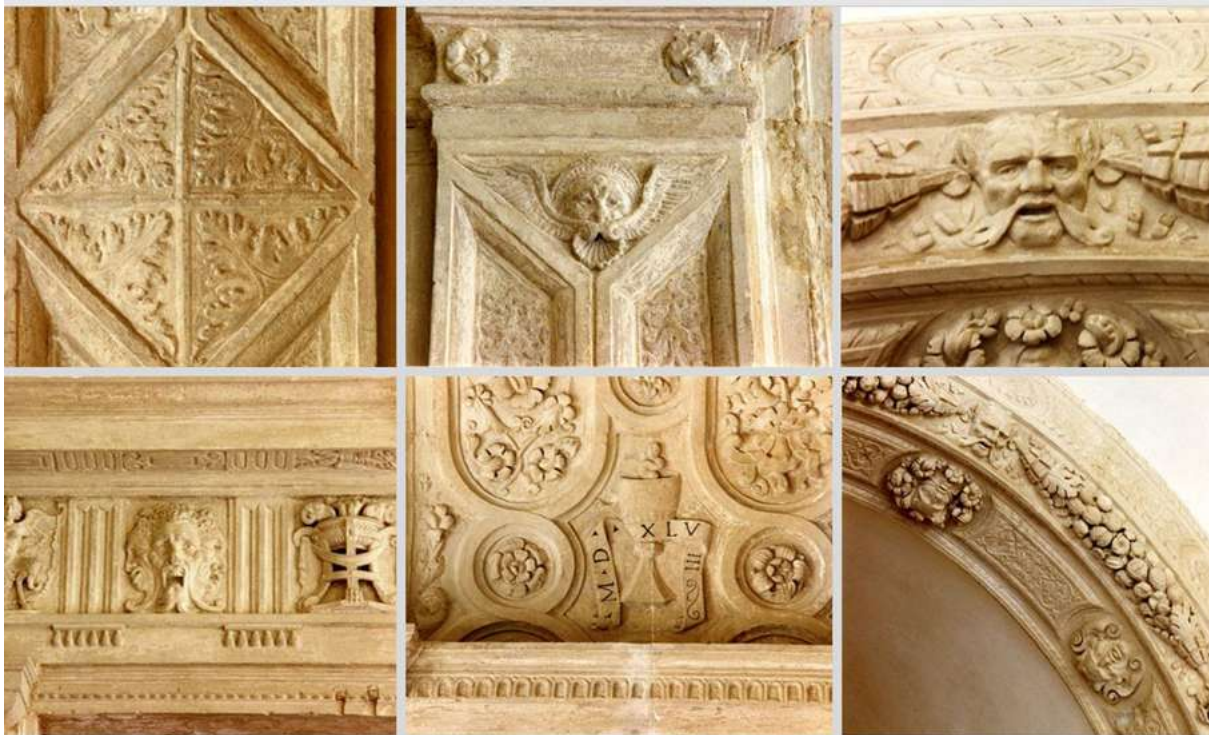
Fig. 37 - Bologna, complesso di San Giovanni in Monte, dettagli delle decorazioni in arenaria.
