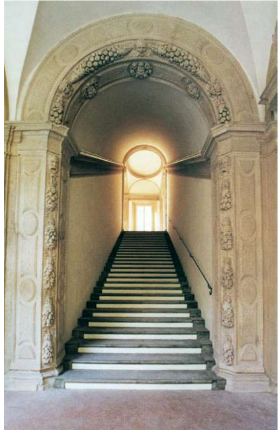
Fig. 22 - Bologna, complesso di San Giovanni in Monte, lo scalone monumentale.
