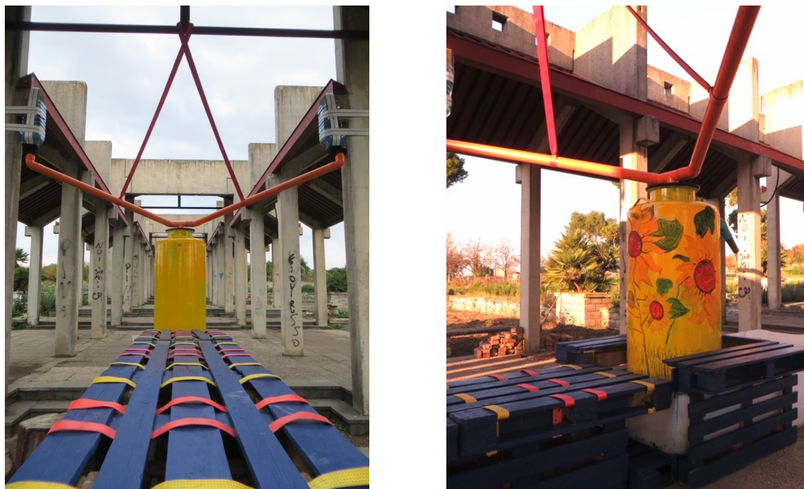
Figura 6: Prototipo per il riuso dell'acqua piovana realizzato e successivamente decorato dagli utenti dell'Orto
