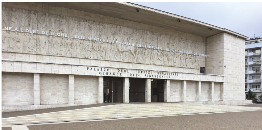
Fig. 1 Casa Littoria, Bolzano. Author's photo.
