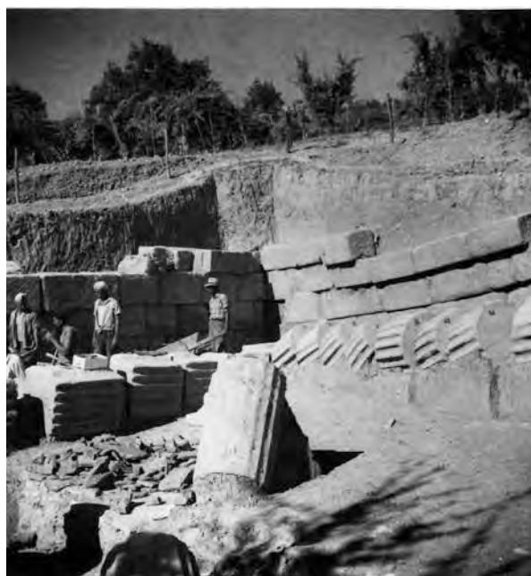
Fig. 44. Una fase degli sterri del secolo scorso con elementi architettonici ancora sparsi sul suolo (A.SABAP-M.).
