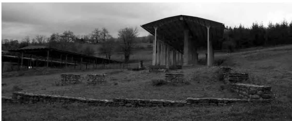
Fig. 49. I resti della 'aula orientale' in primo piano con il portico ricostruito sullo sfondo (A.SABAP-M.).
