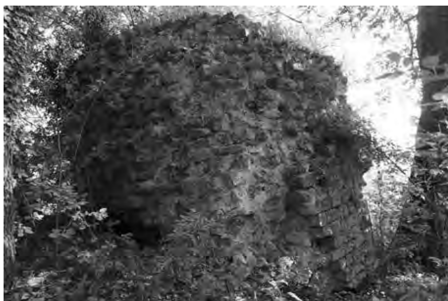
Fig. 28. Resti di strutture murarie medievali presso Bucchiano.
