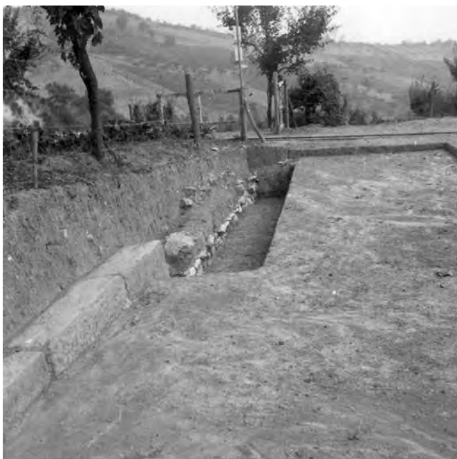
Fig. 62. Il muraglione di contenimento del lato settentrionale del portico visto da ovest in corso di scavo (A.SABAP-M.).
