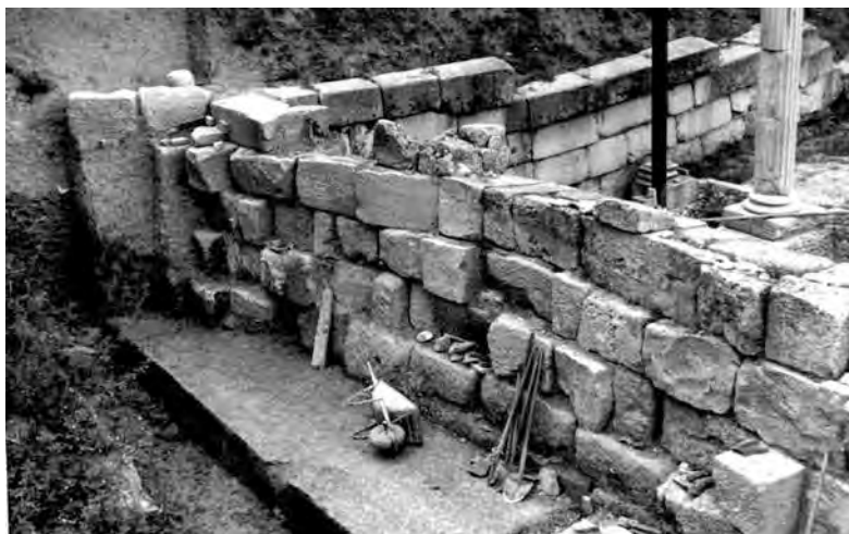
Fig. 89. Il muraglione occidentale in blocchi di arenaria in corso di scavo (A.SABAP-M.).
