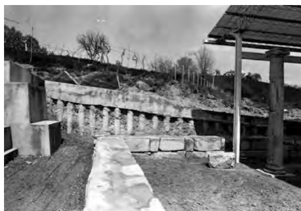
Fig. 38. Il muro settentrionale di contenimento in cemento armato (A.SABAP-M.).
