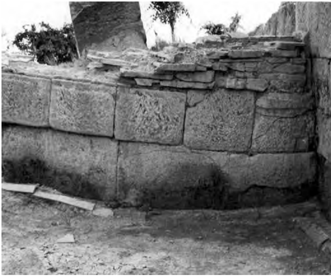
Fig. 68. Il muro occidentale presso l'ammorsatura sull'angolo nord-ovest (A.SABAP-M.)
