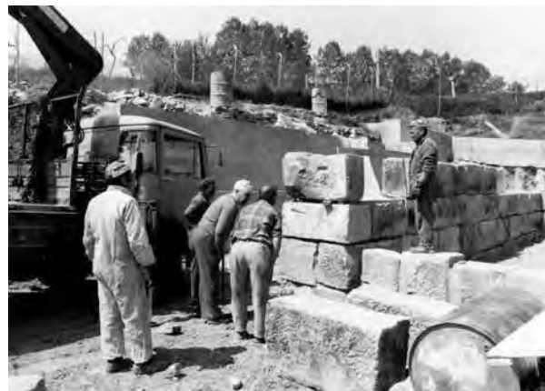
Fig. 36. Il ricollocamento di uno dei blocchi di arenaria (A.SABAP-M.).
