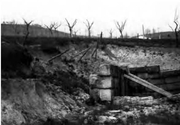
Fig. 33. Il muraglione di contenimento sull'angolo nord-ovest del portico (A.SABAP-M.).
