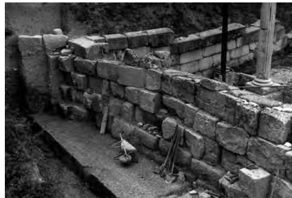
Fig. 34. Il muraglione di contenimento verso monte dopo lo sterro (A.SABAP-M.).
