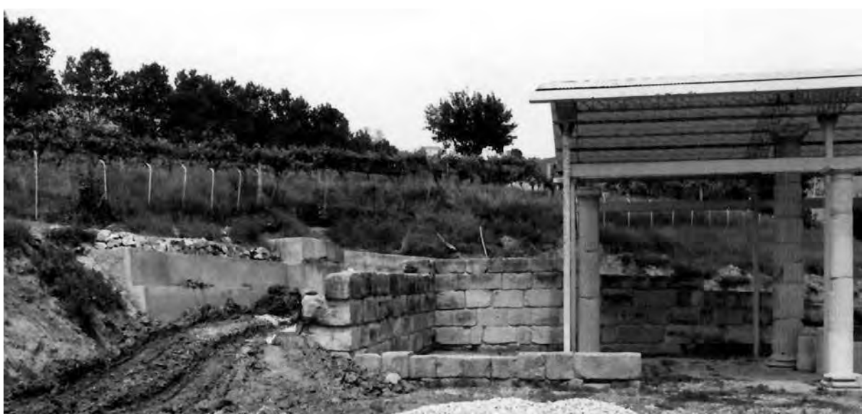
Fig. 39. Il muro di contenimento a gradoni di cemento (A.SABAP-M.).
