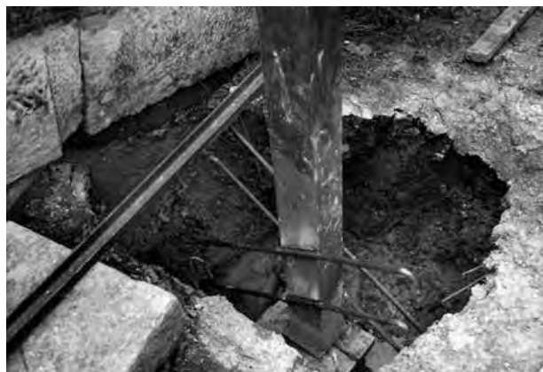
Fig. 26. Scavo per l'alloggiamento dei sostegni della copertura moderna (A.SABAP-M.).
