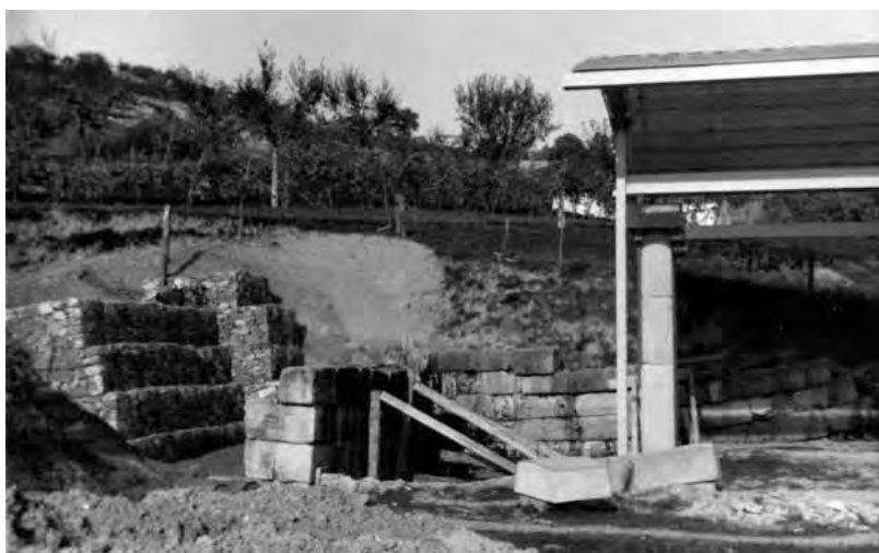
Fig. 14. Angolo Nordovest del portico, anni Sessanta, muro di contenimento della scarpata in pietrame a secco (A.SABAP-M.).
