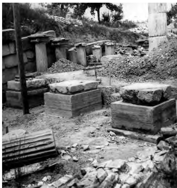
Fig. 28. Rifondazione del colonnato ionico dell'aula sull'angolo nord-ovest (A.SABAP-M.).
