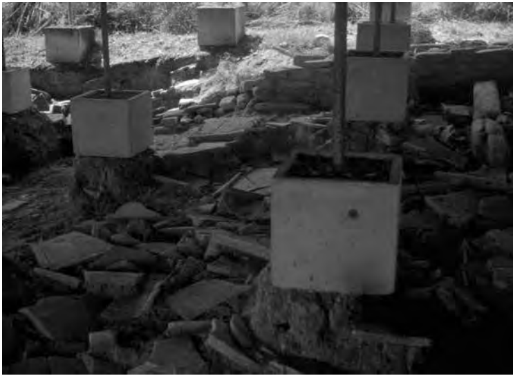
Fig. 96. Il crollo lasciato sul posto negli anni Sessanta (A.SABAP-M.).
