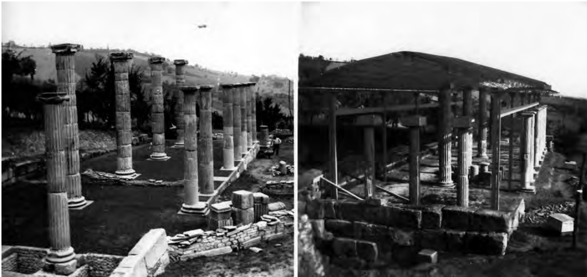
Fig. 5. L'area archeologica dopo l'anastylosi, a sinistra, e la costruzione della coperture moderna, a destra (A.SABAP-M.).
