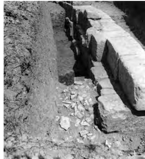
Fig. 48. La rimozione dell'interro nella parte originariamente contro-terra del muraglione in blocchi di arenaria (A.SABAP-M.).
