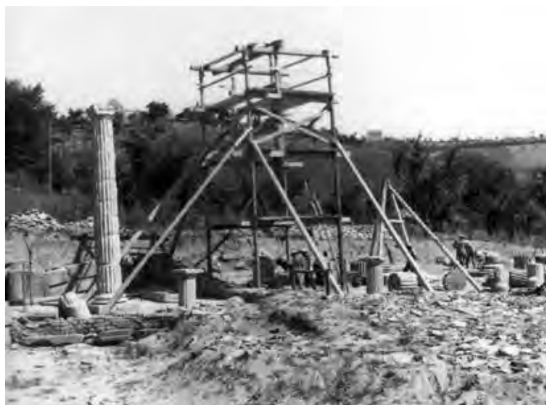
Fig. 22. Il ponteggio per l'anastilosi del portico (A.SABAP-M.).
