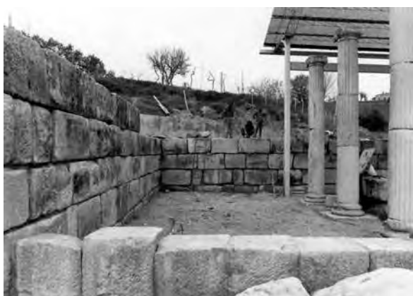
Fig. 37. I muraglioni di contenimento dopo la ricostruzione (A.SABAP-M.).
