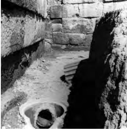
Fig. 40. Pozzetto moderno all'interno del portico (A.SABAP-M.).
