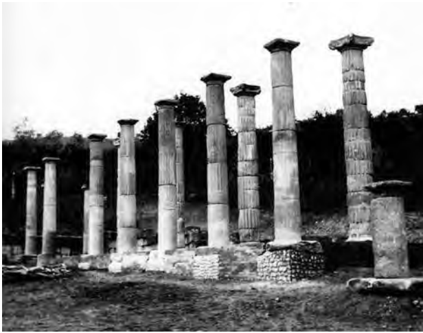
Fig. 31. L'anastilosi del colonnato dorico (A.SABAP-M.).
