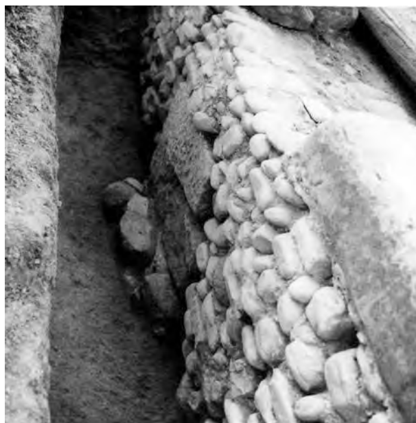
Fig. 67. La fondazione continua del portico dorico con blocchi di riempimento (A.SABAP-M.).
