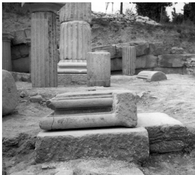
Fig. 45. Allettamento della base modanata per l'anastilosi (A.SABAP-M.).
