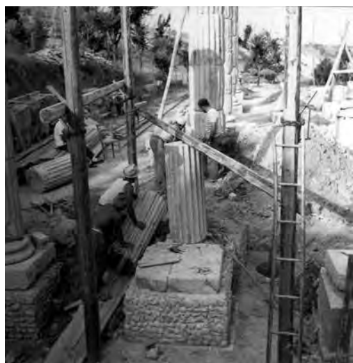
Fig. 28. Rifondazione del colonnato ionico dell'aula sull'angolo nord-ovest (A.SABAP-M.).
