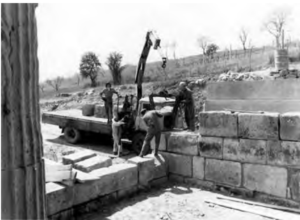
Fig. 35. Una fase del rimontaggio del muraglione di contenimento (A.SABAP-M.).
