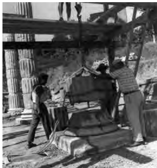
Fig. 21. Anastilosi di una delle colonne del portico (A.SABAP-M.).
