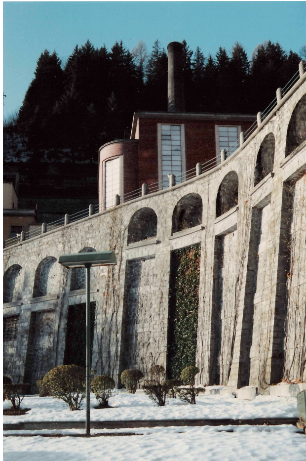
Figura 7. Dalla piazza del teatro la centrale termica e la ciminiera.
