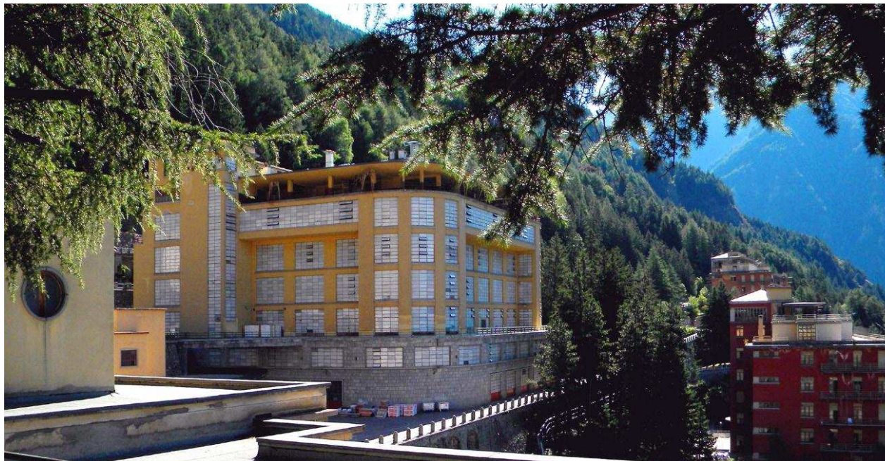
Figura 3. Panoramica del Padiglione dei servizi. A destra i Padiglioni III e V.
