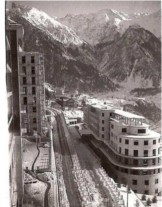
Figura 2. Padiglione Chirurgico in costruzione (1936).
