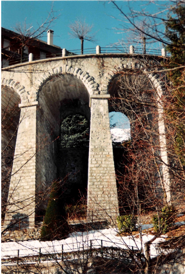
Figura 4. Arcate e muri di sostegno – Viadotti.
