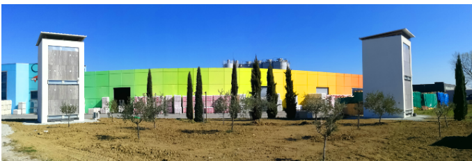
Figura 1 - Edifici test realizzati nell'ambito del progetto Involucro .
