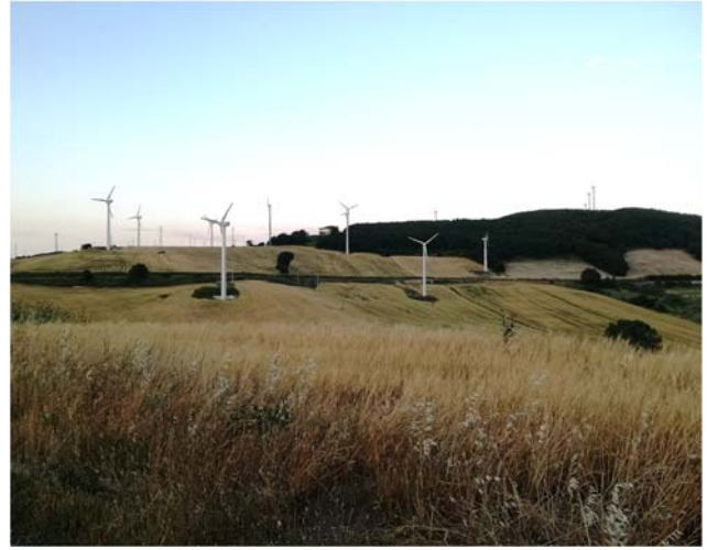
Fig. 7 – Aquilonia. Il paesaggio agricolo con le pale eoliche. Fonte: foto dell’autore.
