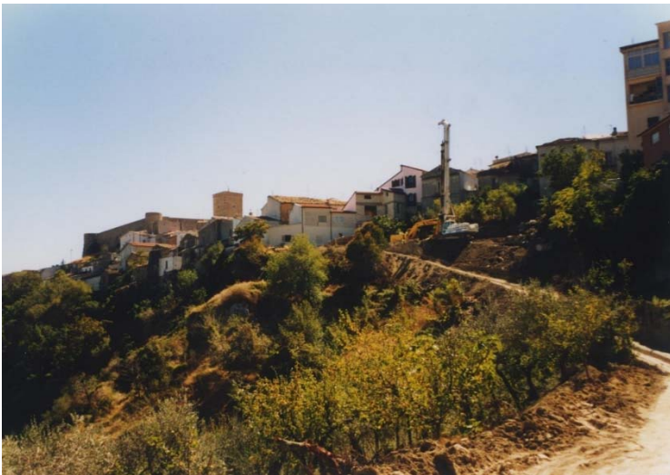
Fig. 7 – Lavori di sistemazione del pendio prospiciente l'abitato di Piazza Europa a Deliceto - Fonte: Progetto IFFI
