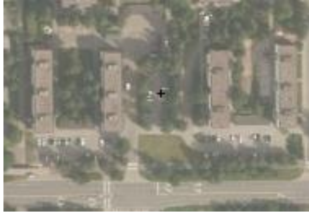
Figure 55 Detail aerial picture of Figure 54 of the Myyrmäki Vaskivuorentie area (60° 15' 51,005", 24° 50' 57,262", https://asiointi.maanmittauslaitos.fi/karttapaikka/ ).
