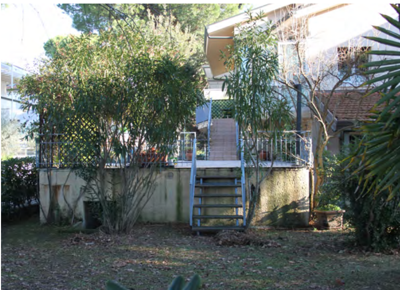
Figure 21-22. Cervia (RA), bunker a servizio di un'abitazione. Si noti il tentativo di ingentilirne l'aspetto tramite il rivestimento e l'impiego di gelosie in terracotta (foto A. Zampini, 2018).
