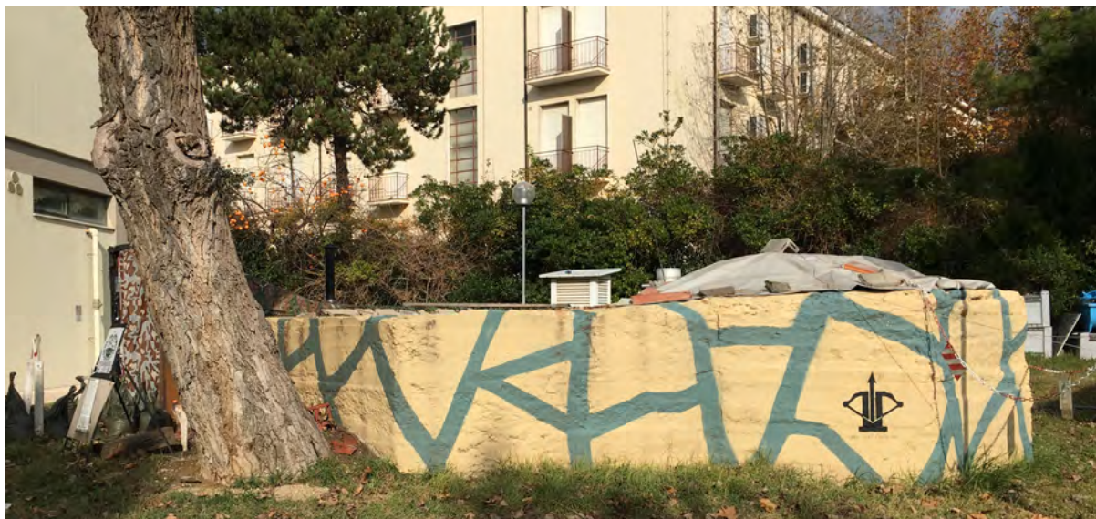
In alto, figure 28-29. Cesenatico (FC). Esempio di dipintura mimetica (foto A. Zampini, 2018); qui sopra e nella pagina successiva, figure 30-31. Cesenatico (FC). Musealizzazione del bunker del Centro di Ricerche Marine (foto C. Mariotti, A. Zampini, 2018).
