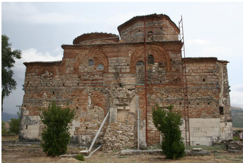
Fig. 6. Chiesa di San Nicola di Mesopotam (XIII sec.), costruita sul basamento di un edificio ellenistico (Foto di E. Cirelli).
