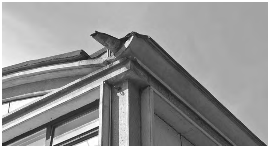
Figura 23. Bruno Violi, Casa Shaio, dettaglio di facciata: si notino l'impostazione tettonica degli elementi e la soluzione d'angolo a "W". Fonte: foto dell'autrice, 2017.
