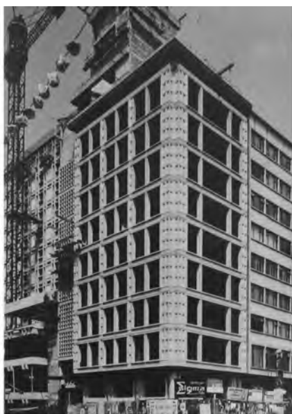
Figura 87. Quintana, foto dell'edificio in costruzione, senza data: si notino la soluzione di solaio pieno e la sagomatura in corrispondenza dell'angolo. Fonte: Universidad Nacional de Colombia, Bogotá D.C., Facultad de Artes, Museo de Arquitectura Leopoldo Rother, Collezione Bruno Violi.
