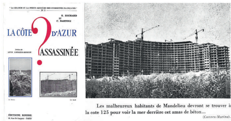
Fig. 1 - Mandelieu: un exemple de bétonnisation littorale
