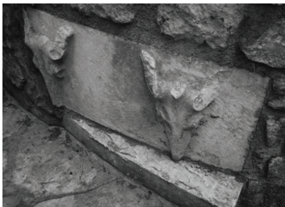
Fig. VI.1.3. Kos, Epta Vimata, particolare della muratura con reimpieghi (foto di L. Orlandi).
