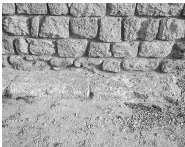
Fig. II.2.2. Basilica Nord, banchine di fondazione (foto di V. Casali).
