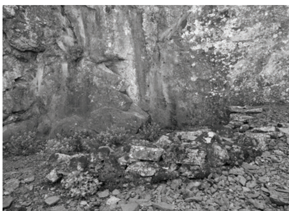
Fig. III.1.6. Kakoskalo, struttura muraria in prossimità di un fronte di cava (foto di G. Marsili).
