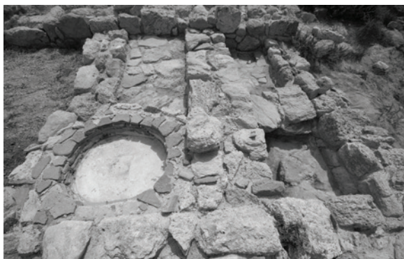
Fig. II.1.39. Annessi S, vano VIII. In primo piano la vasca USM 75, addossata al tramezzo preesistente (USM 74) e collegata al setto murario USM 76 (foto di G. Marsili).
