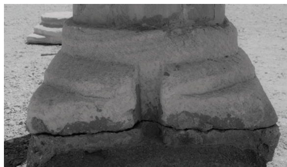
Fig. II.1.14. Basilica Sud, stilobate tra navata centrale e navata N, base di colonna BA9 con incasso per pluteo (foto di V. Casali).
