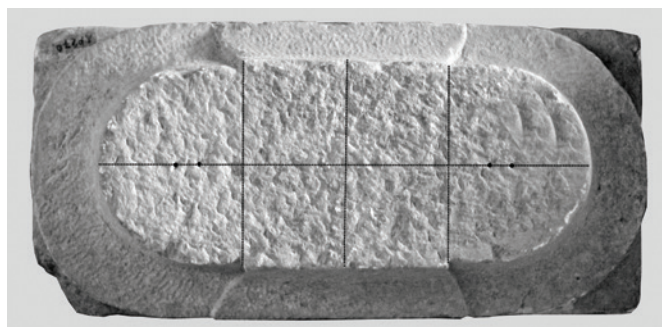
Fig. III.1.14. Kos, Kastro di Neratzia, base di colonna binata con tracciati geometrici sul letto di attesa (foto di G. Marsili).
