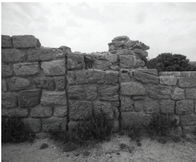
Fig. II.3.7. Porta tamponata USM 106 (foto di V. Casali).
