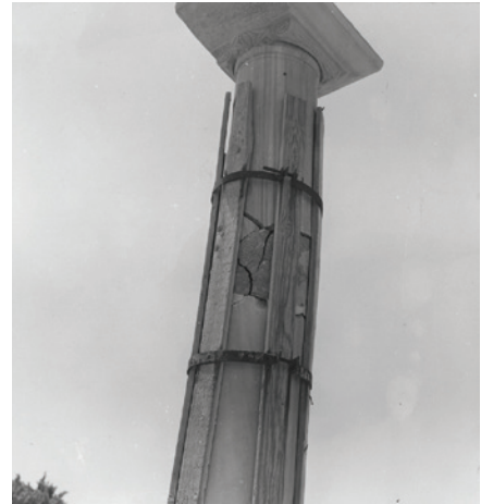
Fig. I.3.2.7. S. Stefano, Vano IV. Particolare dell'anastilosi della colonna S-O (IV Eforia Bizantina del Dodecaneso).
