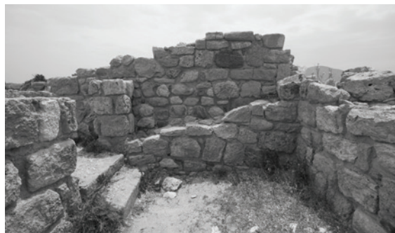
Fig. II.2.25. Basilica Nord, narcece. Muro a sacco (a destra) realizzato all'interno dell'ambiente (foto di V. Casali).
