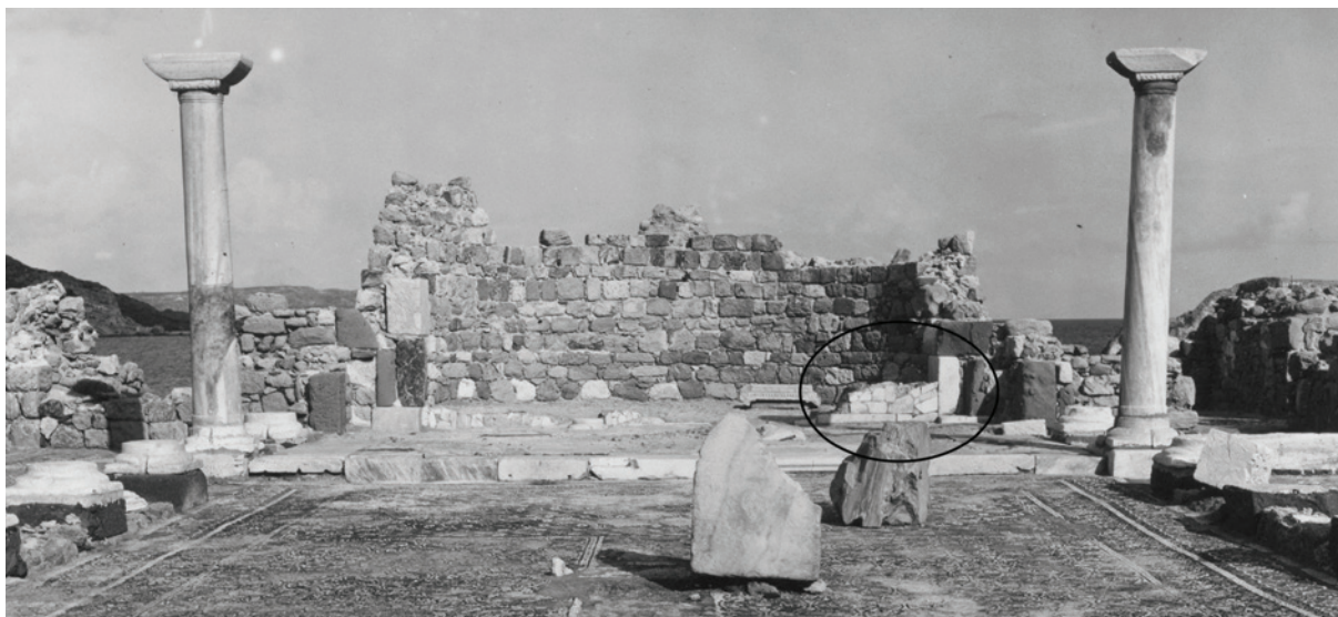
Fig. II.1.29. Basilica Sud, area presbiteriale (vano IV). Nell'ovale la spalletta O del synthronon all'epoca degli scavi (Archivio SAIA).
