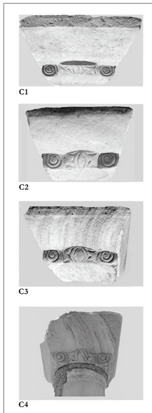
Fig. III.2.1.5. S. Stefano, Basilica Sud, capitelli imposta ionici C1-4, decorazione dell'echino, lato primario (foto di V. Casali).
