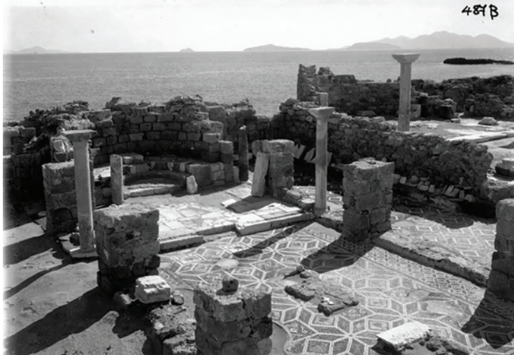
Fig. II.2.8. Basilica Nord, alcuni interventi di anastilosi nell'area presbiteriale (Archivio SAIA).
