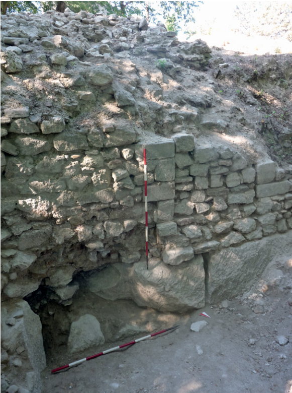
Fig. 3. Porta di accesso alla Rocca duecentesca del castello di Rontana direttamente impostata sul muro perimetrale della pieve.
