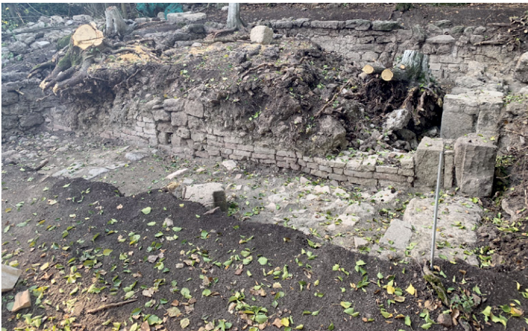
Fig. 1. Castello di Ceparano. Muro divisorio di abitazione medievale (XI-XII sec.) costruito con laterizi di produzione tardoimperiale (sesquipedali manubriati).
