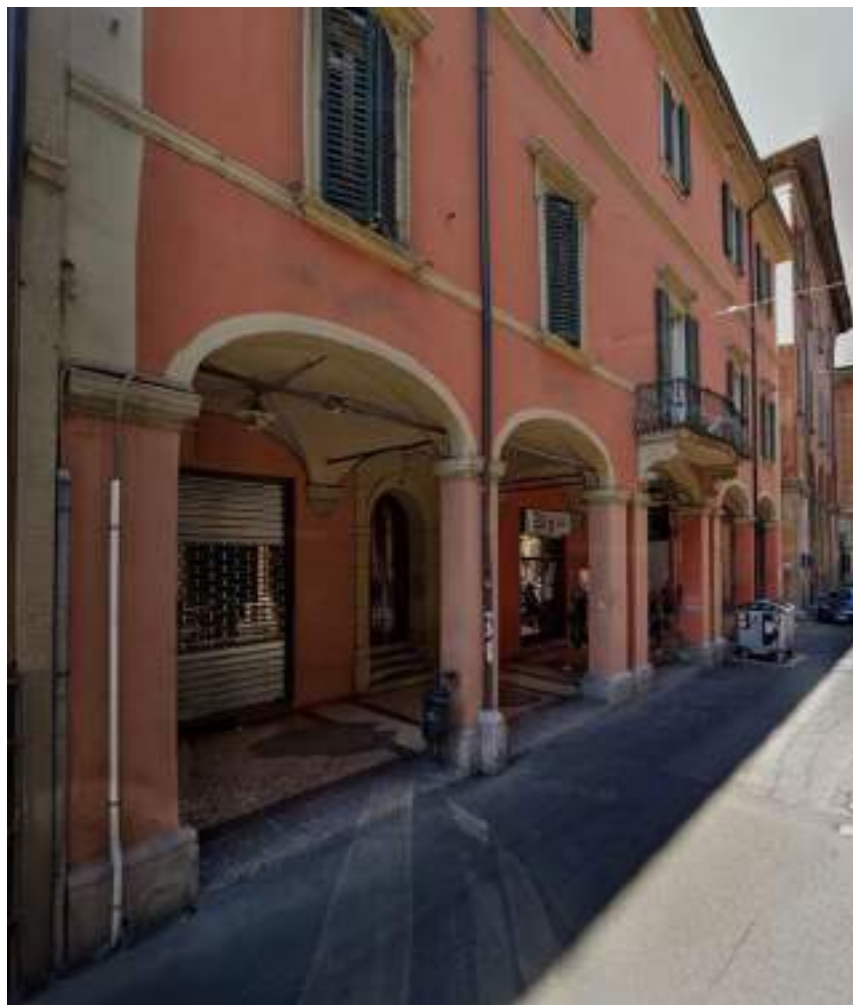
7. Bologna, casa delle Vedove Bugami, facciata
