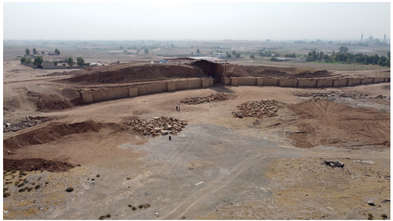
Fig. 8. Lo stesso tratto di mura della fig. 7, rimesse in luce dopo la rimozione delle macerie grazie al sostegno del J.M. Kaplan Fund. I blocchi crollati della ricostruzione moderna sono stati accumulati in vista dei successivi interventi di anastilosi.
