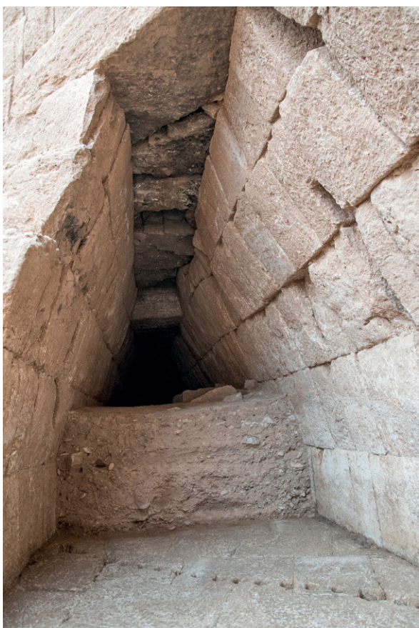
Fig. 10. L'ingresso esterno del canale sotto alle mura nell'area G, VII sec. a.C.: si notino i fori sul fondo lastricato per una perduta grata di chiusura in ferro. Il soffitto nella parte esterna è composto da merli in pietra riutilizzati.
