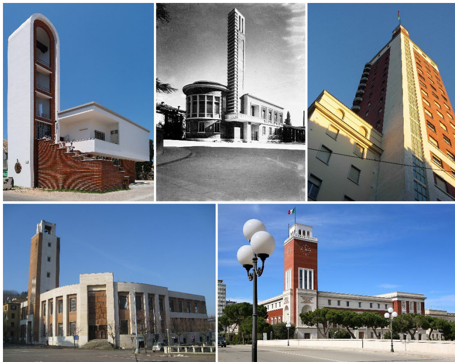
Fig. 7. Other rationalist towers of the early ‘1930s: Casa del Fascio in Mussolinia (Arborea - OR); Palazzo Littorio in Montevarchi (AR); Torre Littoria (TO); Casa del Fascio in Predappio (FC); Palazzo di Città (PE) (composition of public domain photos: all pictures retrieved from Wikipedia under CC BY-SA 2.0)
