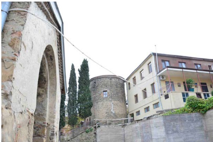
Figura 6. Presenza di cavi sospesi. Foto: Giuseppe Maino.
