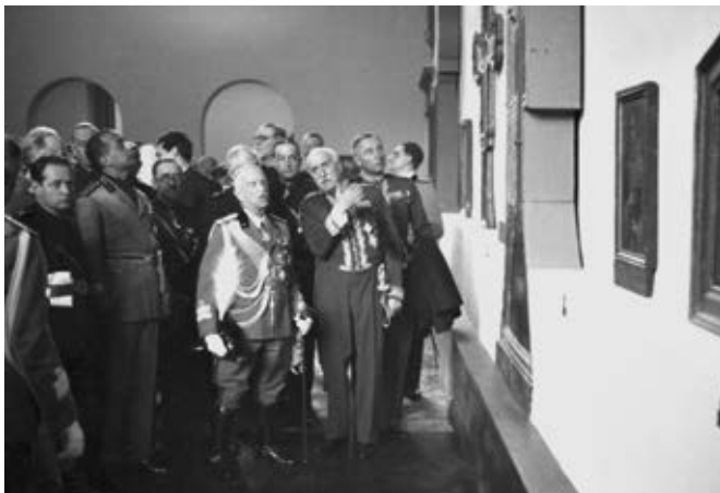
1 Fotografia storica che illustra l'allestimento del salone principale al piano primo, dove è visibile la parte inferiore di un grande crocifisso "annegata" nello zoccolo continuo (© Archivio Foto Locchi)
