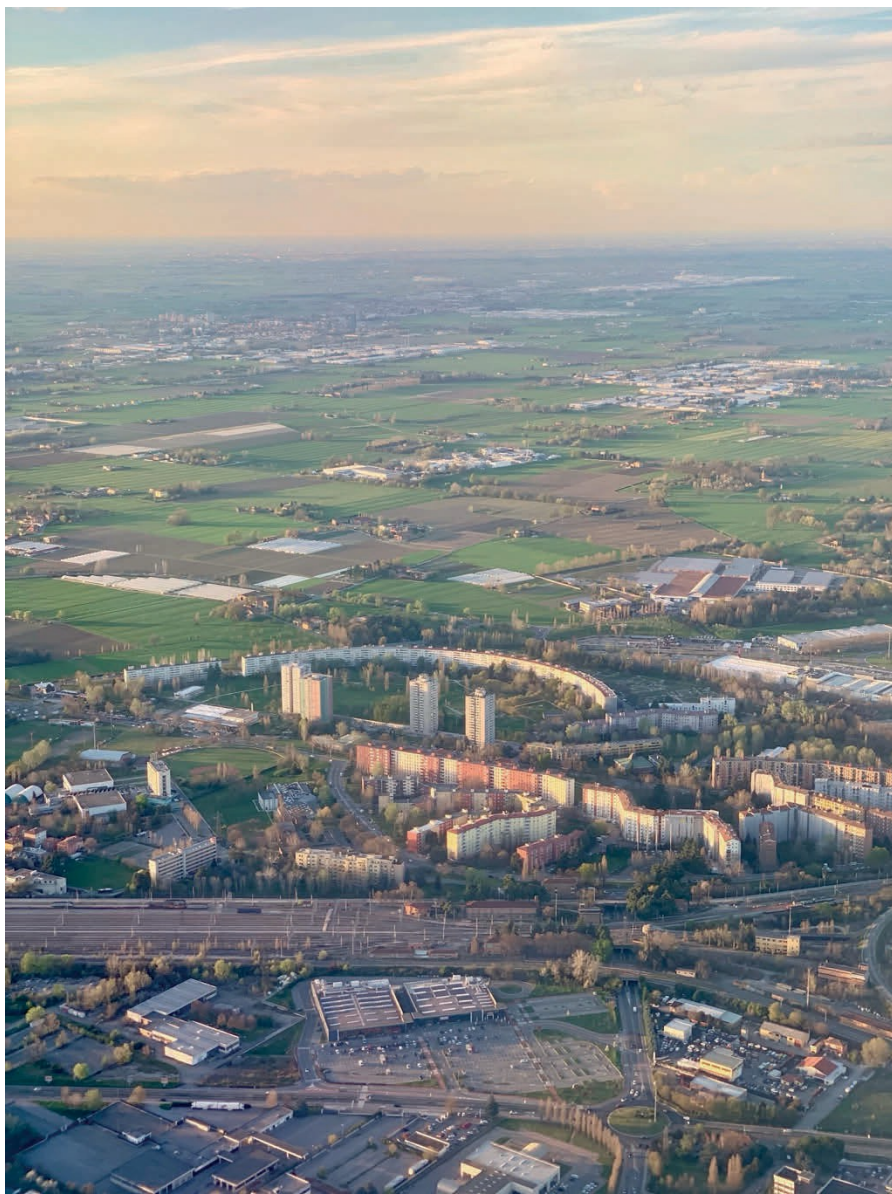
Fig. 5.2 - Foto aerea del rione Pilastro e di parte dell'area industriale Le Roveri (separata dallo scalo ferroviario dismesso), Bologna. Foto di Saveria Boulanger
