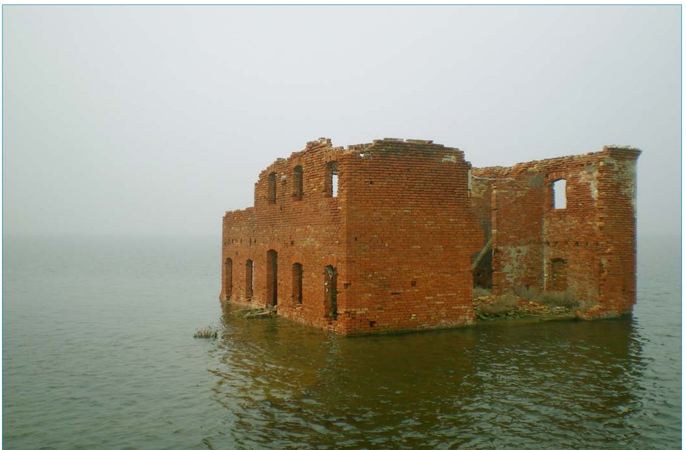
Fig. 3 – Venezia, Laguna Sud. Il casone Prime Poste (foto S.M.).
