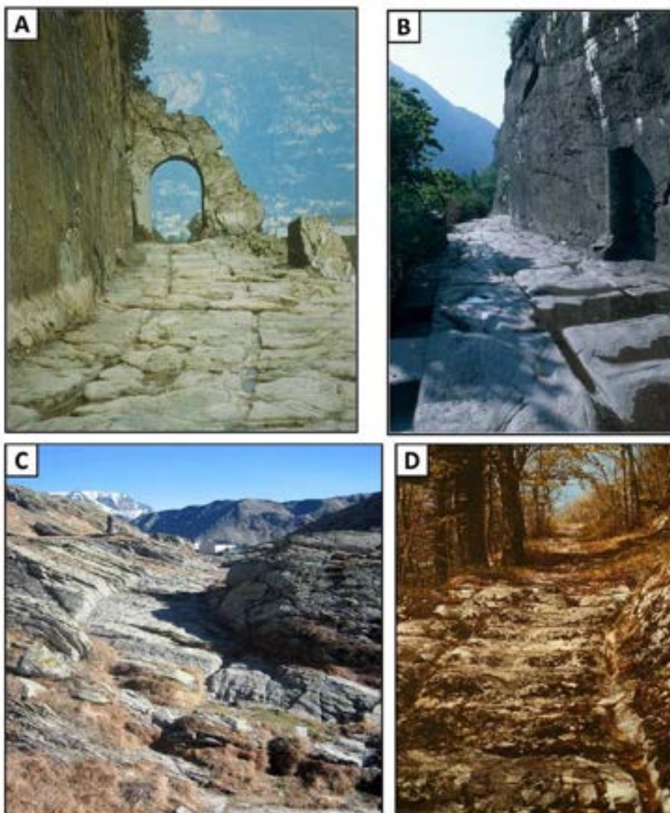
Figura 5 - Esempi di strade romane di ambito alpino ricavate interamente nella roccia: a-b) la “via delle Gallie” a Donnaz (Aosta); c) la “via delle Gallie” presso il passo del Gran San Bernardo; d) tratto della “via salina” nei pressi di Vuiteboeuf (Cantone di Vaud, Svizzera).
