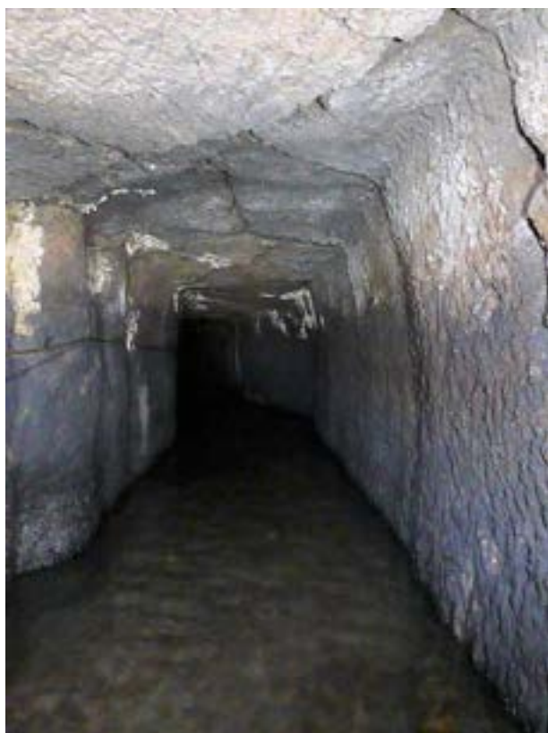
Figura 4 - Salone. Il canale principale dell'Aqua Virgo scavato nel banco roccioso.
