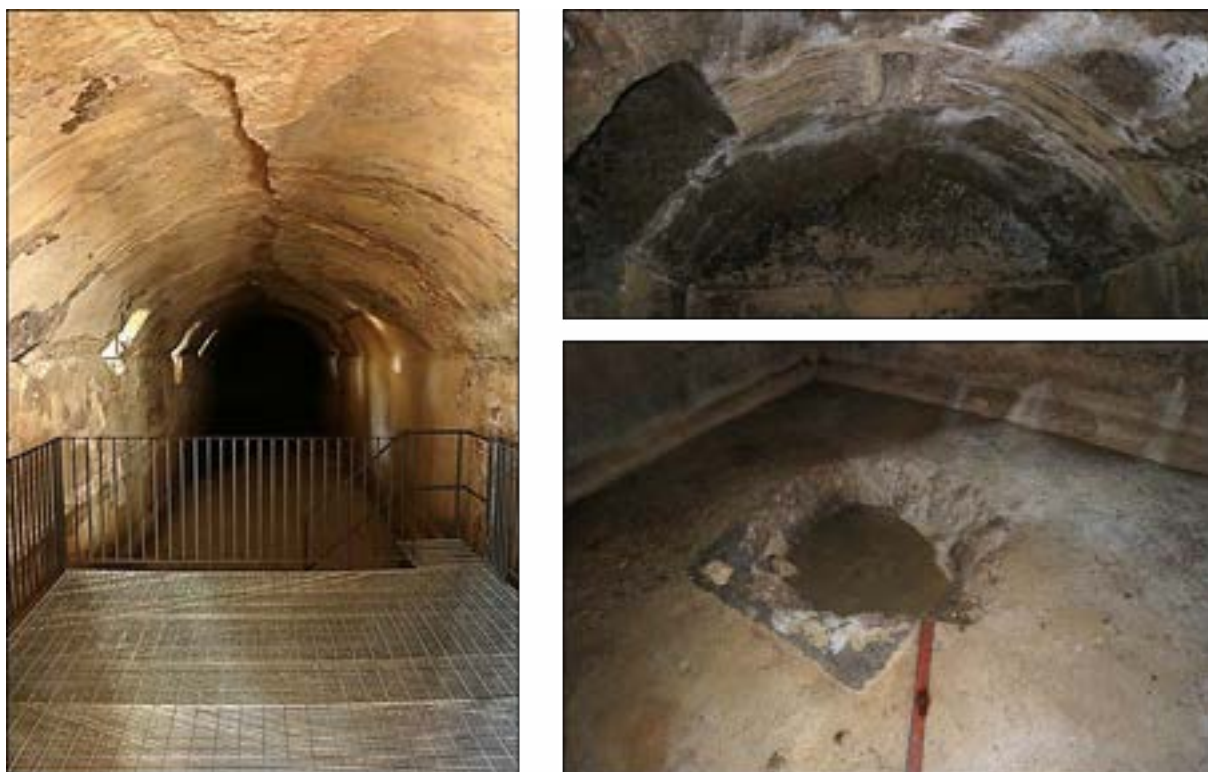
Figura 5 - Immagini dell'interno della piscina limaria. A destra visuale dal punto di visita turistico accessibile da lato meridionale della struttura: si noti la vistosa lesione al cervello della volta. In alto a destra il foro rettangolare presente sulla porzione settentrionale della volta e circondato da spesse concrezioni calcaree che si estendono anche oltre lungo l'intradosso della volta: si tratta inequivocabilmente del punto di ingresso dell'acqua nella struttura. In basso a destra la lacuna nel cementizio e nel rivestimento in cocciopesto sul pavimento in corrispondenza del foro d'ingresso a nord. Si noti l'area squadrata in cui il cementizio è esposto e lo strato di calcare sembra risalire verso l'alto: sicuramente si tratta dell'alloggiamento di un elemento litico utile a smorzare la forza dell'acqua in ingresso del foro soprastante.
