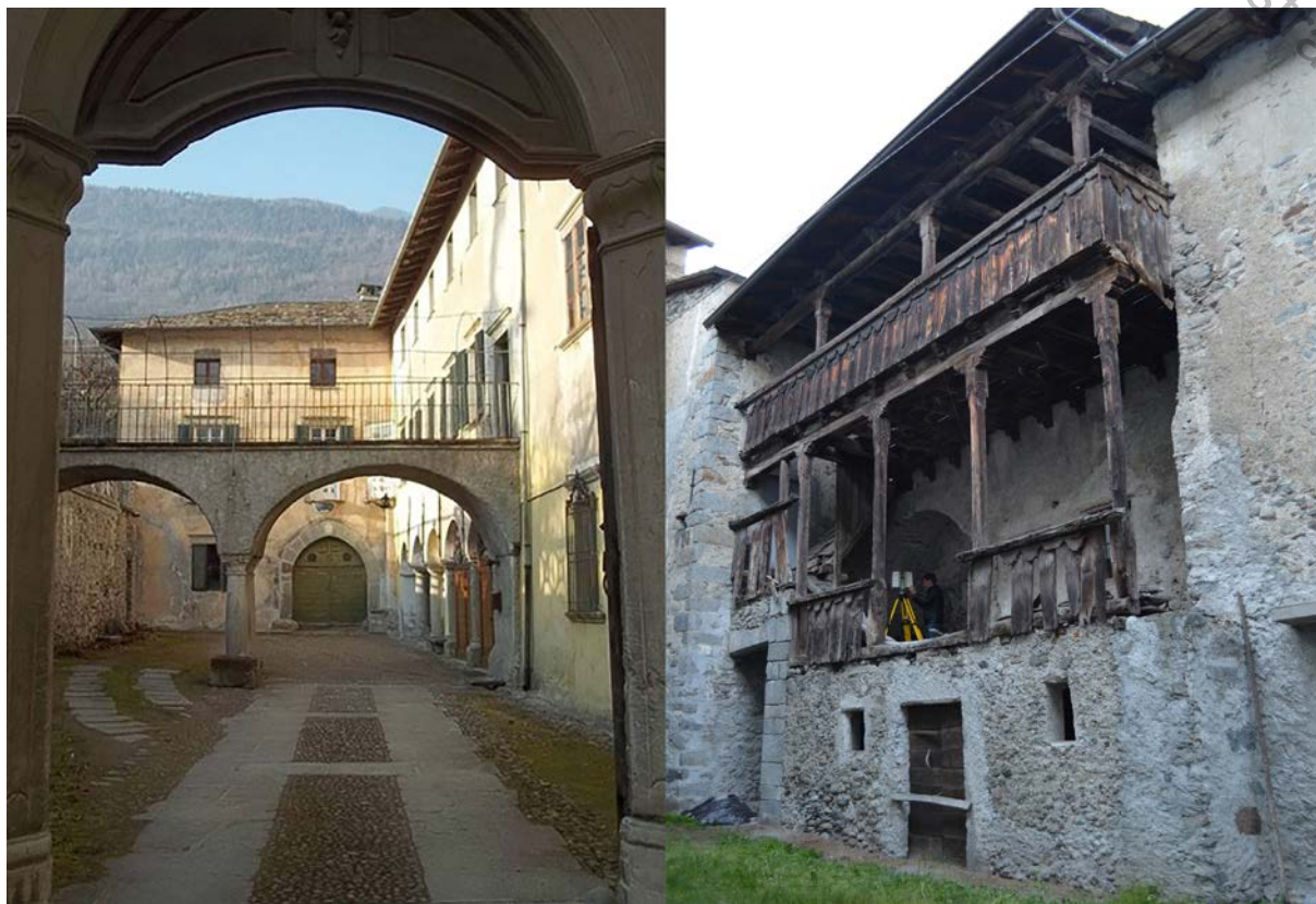
Figura 3. Corti interne e lobbie caratterizzano gli spazi di transizione dal pubblico al privato, generando spazi multifunzionali – per deposito, commercio, di servizio alla residenza – di grande interesse.
