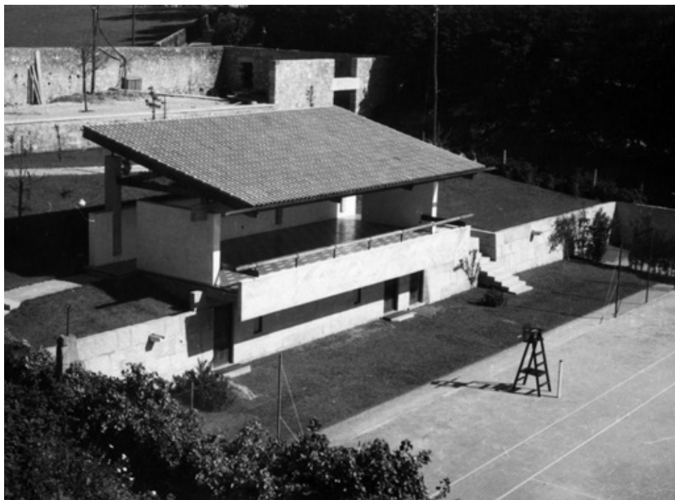
Il patio rosso in costruzione sullo sfondo del padiglione del tennis già ultimato.
